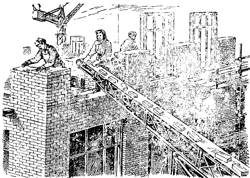
Рис. 65. Кирпичи удерживаются силой трения на ленте транспортёра.
